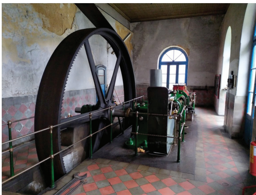
FIG. 5 – Interior da casa da máquina a vapor, no edifício n.º 22.
